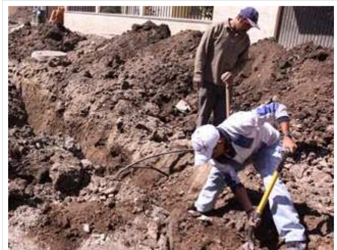
Obras inconclusas en la capital del estado. Foto: Elizabeth Velázquez
